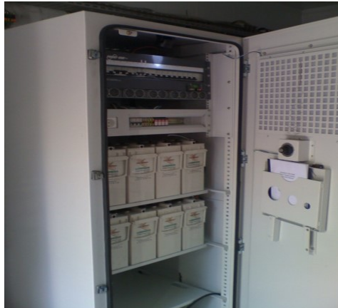
Gambar 3.24 Rectifier Guardian FMP25.48[13]
