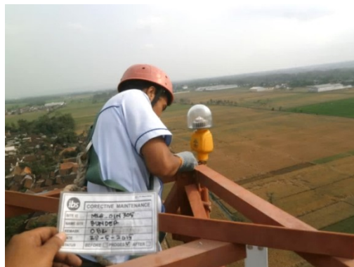
Gambar 4.27 Proses pemasangan lmapu OBL
