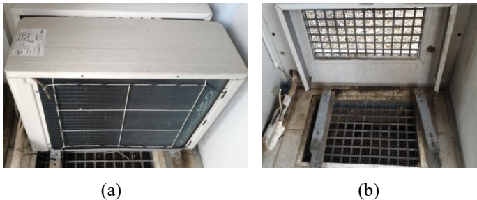
Gambar 4.23 Body AC sebelum dilepas(a) sesudah dilepas(b)
