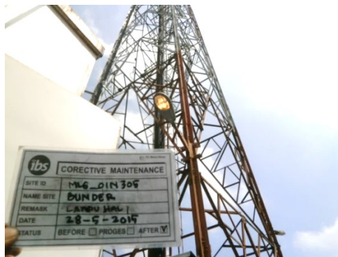
Gambar 4.31 Setelah penggantian lampu tower
