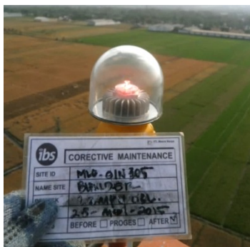
Gambar 4.28 Setelah pemasangan lampu OBL
