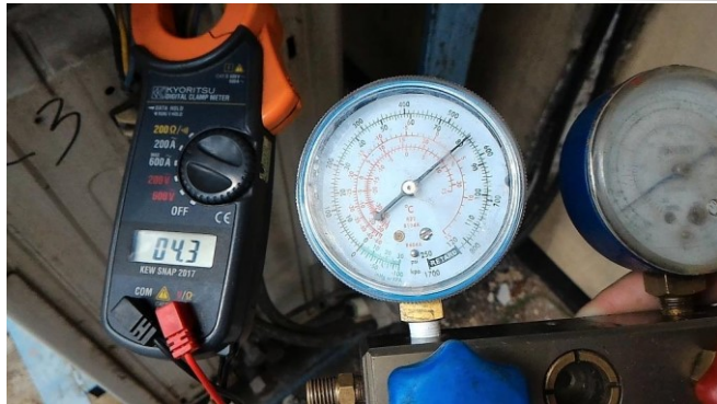
Gambar 4.18 Pengukuran tekanan freon dan arus listrik
