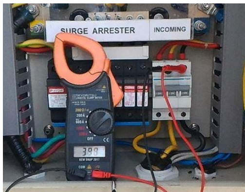
Gambar 4.8 Pengukuran tegangan listrik fase S-T
