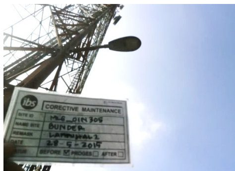
Gambar 4.29 Sebelum penggantian lampu tower
