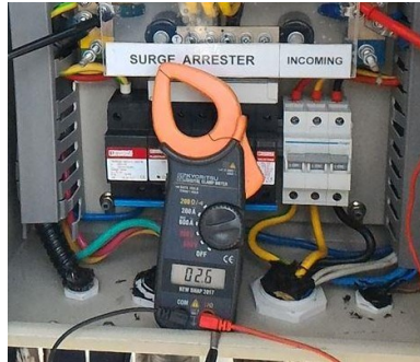
Gambar 4.11 Pengukuran tegangan listrik fase N-G
